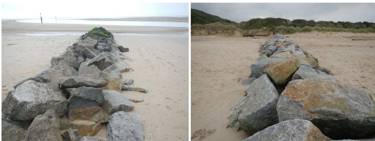
Vue des parties basse (à g.) et haute (à d.) de l'épi n°1 reconstruit en 2014 à la Pointe de Cabourg
