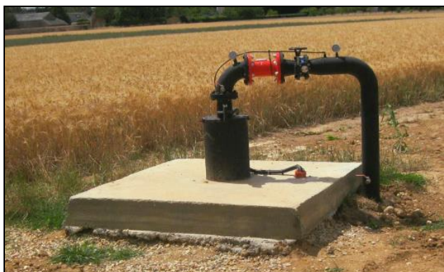
Exemples d'aménagement de génie-civil de têtes de forage dédiés à l'irrigation de cultures et aux besoins des cheptels
