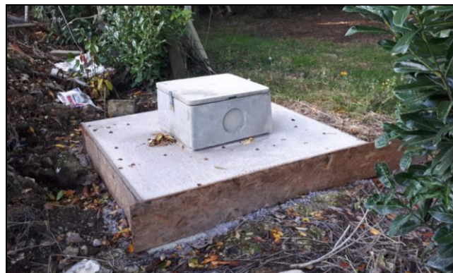
Exemples d'aménagement de génie-civil de têtes de forage dédiés à l'irrigation de cultures et aux besoins des cheptels
