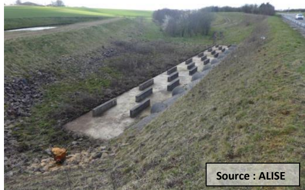
Photo 15 Canalisations permettant la traversée de la déviation
