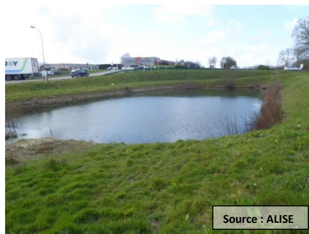
Photo 64 Bassin d'infiltration à l'entrée de la zone d'activité
