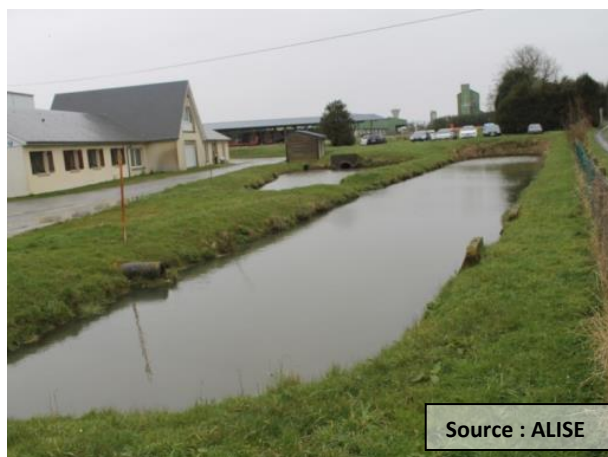
Photo 72 Bassin de traitement des eaux pluviales d'Agy Li
