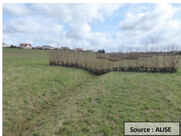
Photo 12 Alignement de fascines au niveau du cimetière
