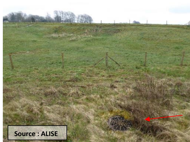
Photo 40 Avaloir permettant la vidange de la cuvette le long de la RD 10
