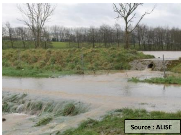
Photo 55 Déversement du bassin de rétention sur la route de Longueil
