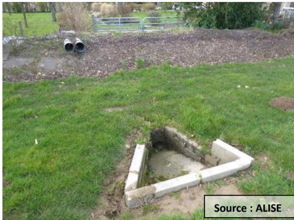
Photo 33 Buse permettant le passage sous le talus et buses de surverse
