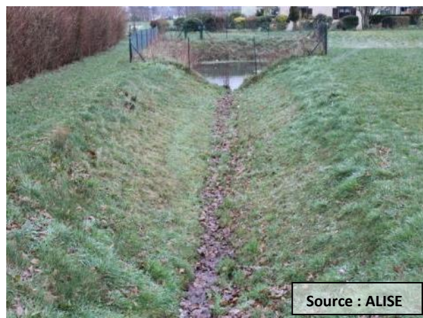
Photo 82 Bassin d'infiltration du complexe sportif de la zone 12
