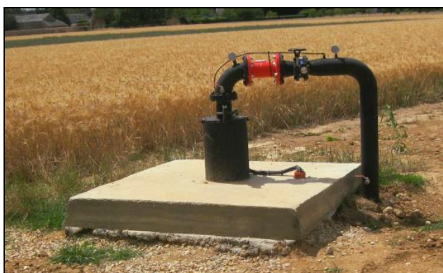
Exemples d'aménagement de têtes de forage dédiés à l'irrigation de cultures et aux besoins des cheptels (Photographie : GéoSen – Juil-20)
