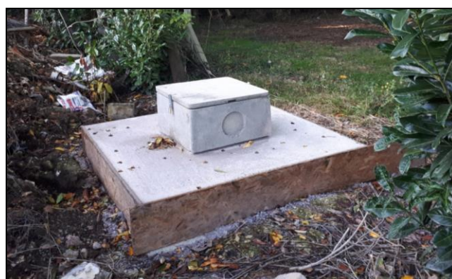
Exemples d'aménagement de têtes de forage dédiés à l'irrigation de cultures et aux besoins des cheptels (Photographie : GéoSen – Juil-20)
