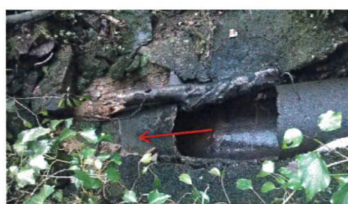
Canalisation de sortie DN 500
