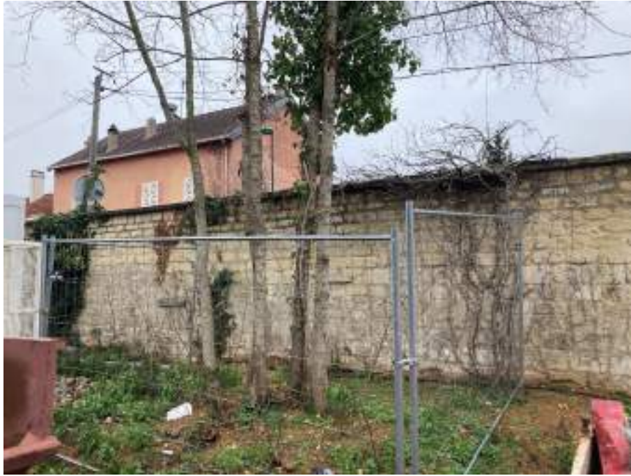
Figure 63 : Balisage d'arbres à conserver sur un chantier d'Île-de-France © ARP-Astrance 2021
