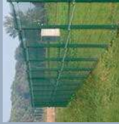
▲ Treillis soudé de 2,00m de haut le long de la voie SNCF
