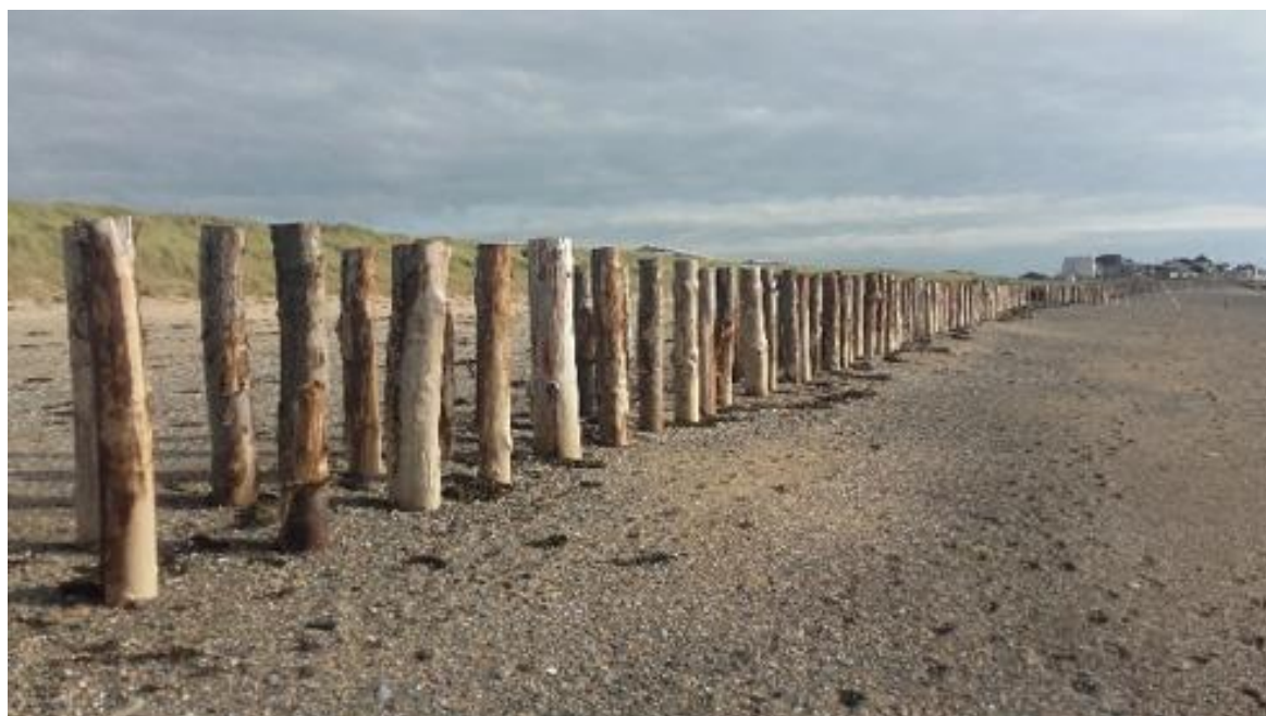
Figure 5 : Illustration d'implantation des pieux hydrauliques
