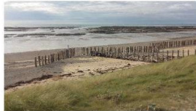
Pieux hydrauliques et fascines (11/10/17) La Poulette, Agon-Coutainville Coutances mer et bocage
