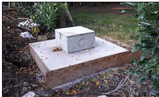
Exemples d'aménagement de têtes de forage dédiés à l'irrigation de cultures et aux besoins des cheptels
