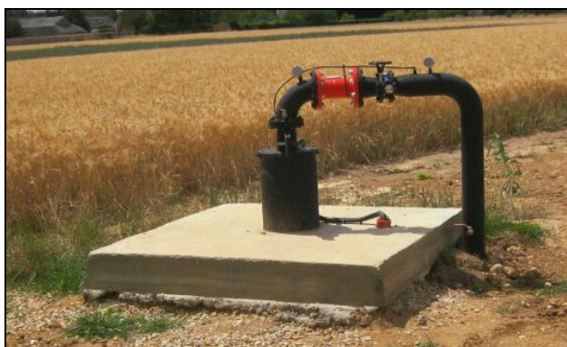
Exemples d'aménagement de têtes de forage dédiés à l'irrigation de cultures et aux besoins des cheptels
