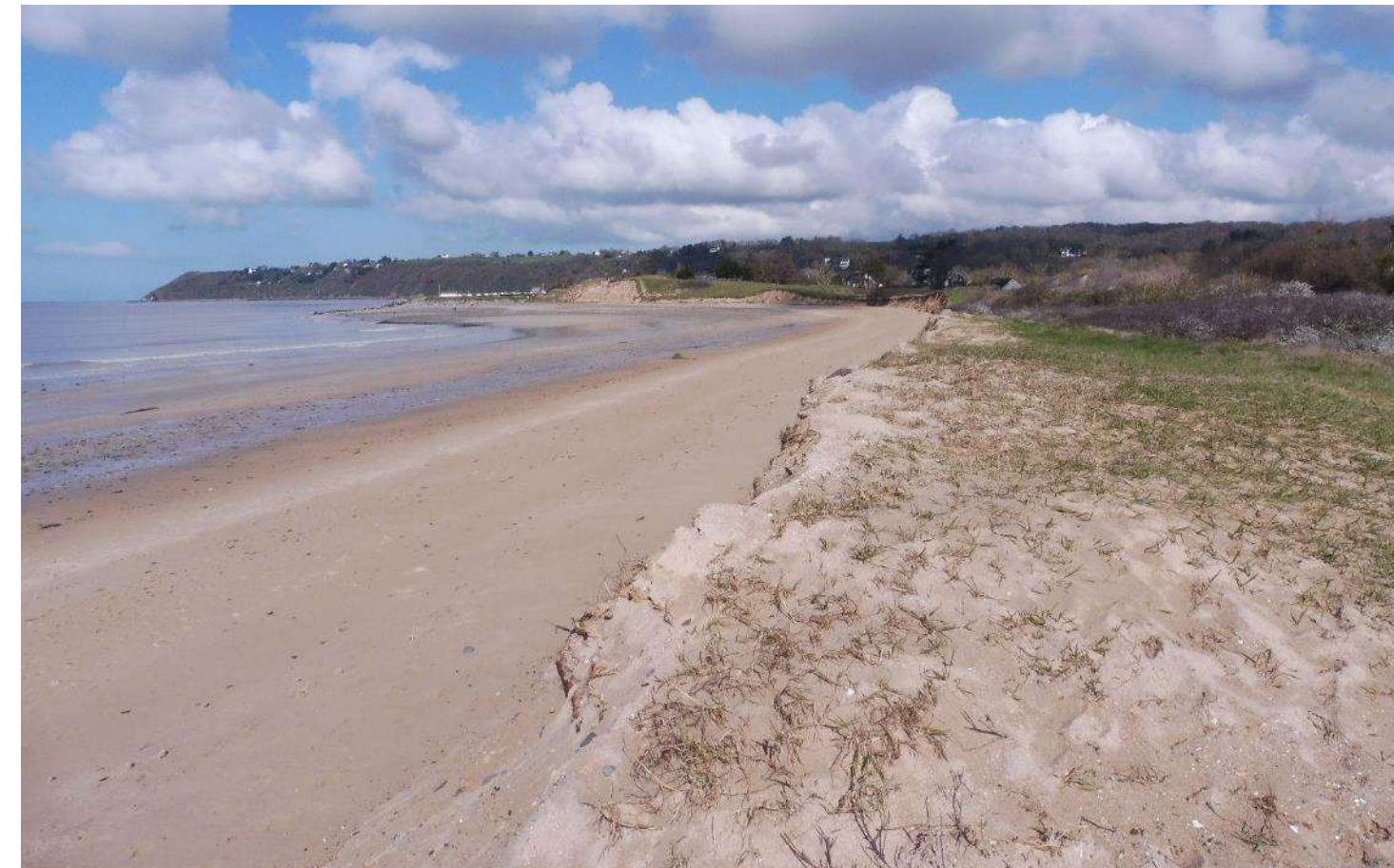
Le 16/03/2020 – après une marée de coefficient 117 et un rechargement en sable de 3 000 m 3 (point 3)
