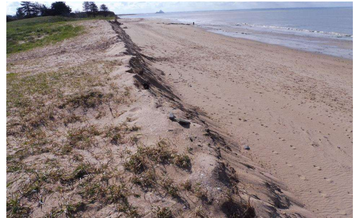
Le 16/03/2020 – après une marée de coefficient 117 et un rechargement en sable en urgence de 3 000 m 3 (point 3)
