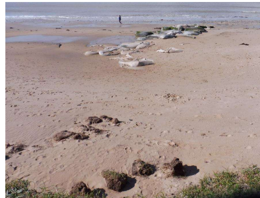
Le 16/03/2020 – après 3 tempêtes, une marée de coefficient 117 et un rechargement en urgence en sable de 3 000 m 3 . Secteur le plus à l'aval du projet de rechargement de 15 000 m 3 , vue vers l'ouest (point 1)
