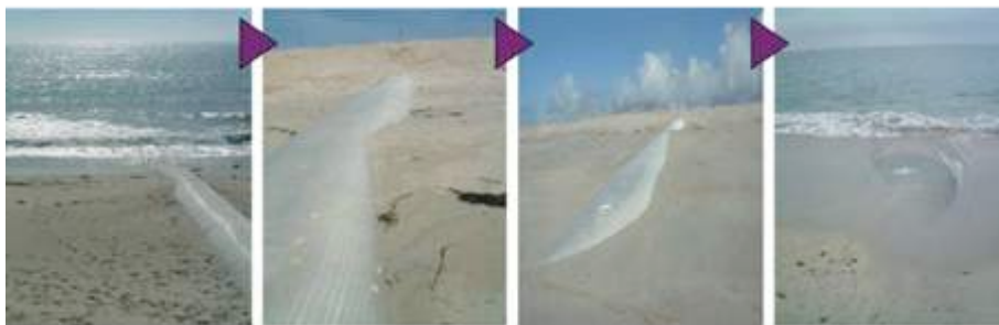
Figure 7 : captage sédimentaire sur une structure STABIPLAGE®
