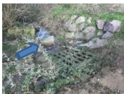
Exutoire commun des réseaux des eaux usées (PVC à gauche de la vailleuse) et pluviales (grille)
