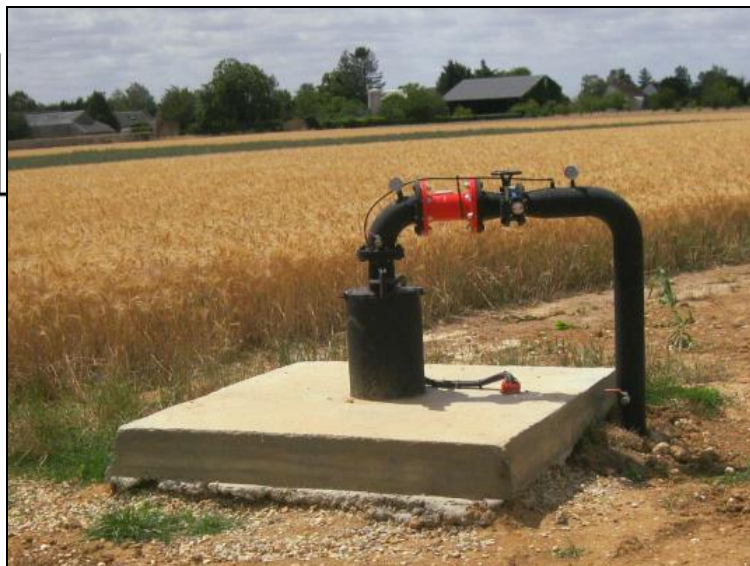
Exemple d'aménagement de tête de forage dédié à l'irrigation des cultures (Photographie : GéoSen – Juil-20)
