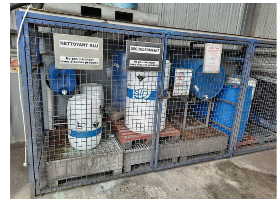
Stockage produit biocide sur bac de rétention
