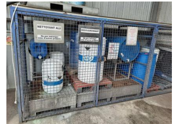
Stockage produit biocide sur bac de rétention
