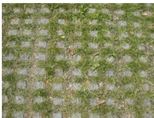
Pavés de béton dans une matrice terreuse enherbée (crédit : SMBV Pointe de Caux)
