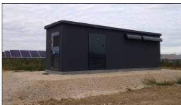
Exemple de poste électrique (livraison et transformation)
