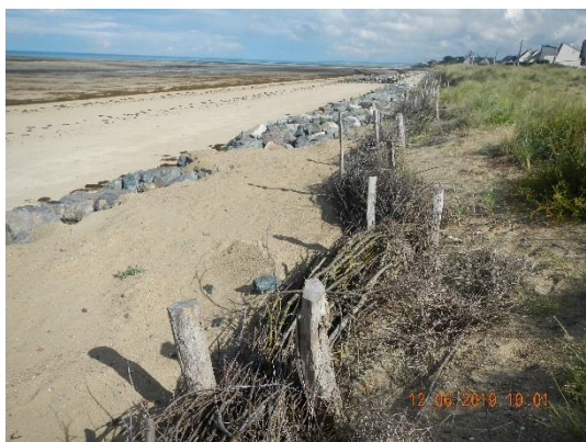
Figure 6. Fascines mises en place pour limiter l'érosion de la dune (cliché LITTO Consult, juin 2019)
