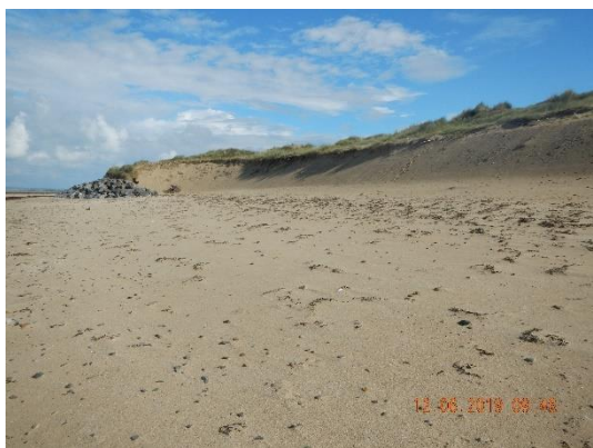
Figure 8. Recul de la dune à l'extrémité Sud du perré – Vue avant rechargement (cliché LITTO Consult, juin 2019) ...
