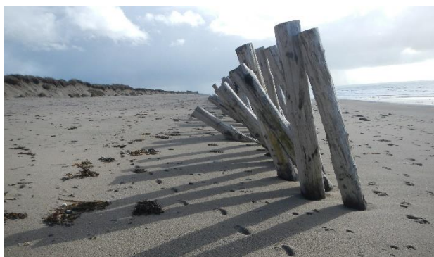
Figure 45. Basculement des pieux hydrauliques à Blainville-sur-Mer
