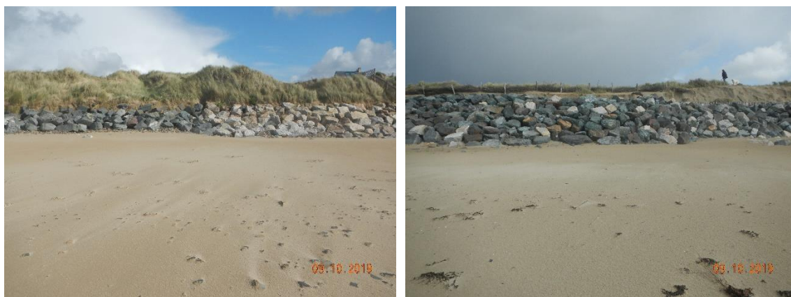
Figure 16. Vue du cordon d'enrochement de pied de dune, au Nord de l'épi 1 (à gauche) et au Sud de la cale de la rue de Colmar (à droite) - Clichés CASAGEC, 09/10/2019
