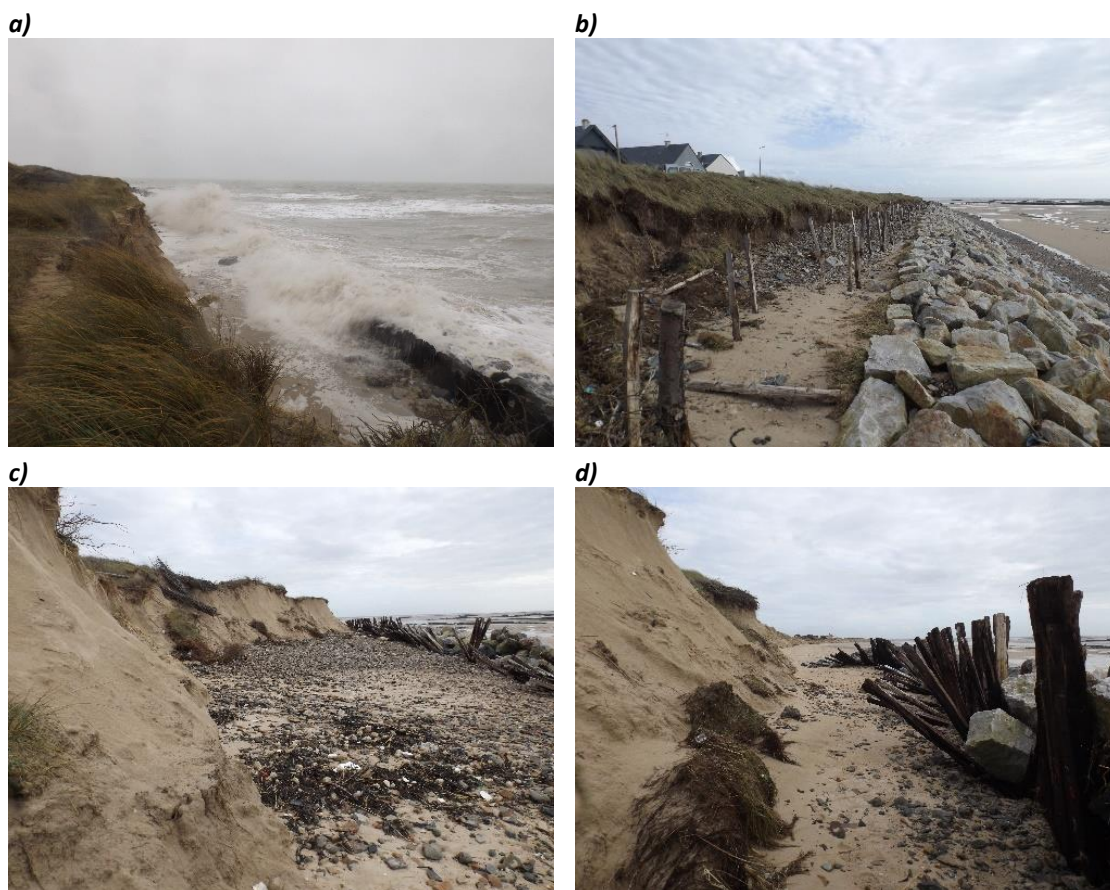
Figure 24. Illustration des franchissements constatés à pleine mer le 11 mars 2020 (a) et recul du trait de côte constaté le 13 mars en arrière de l'ouvrage de la cale sud au musoir du perré (b à d) – Clichés COCM, mars 2020.
