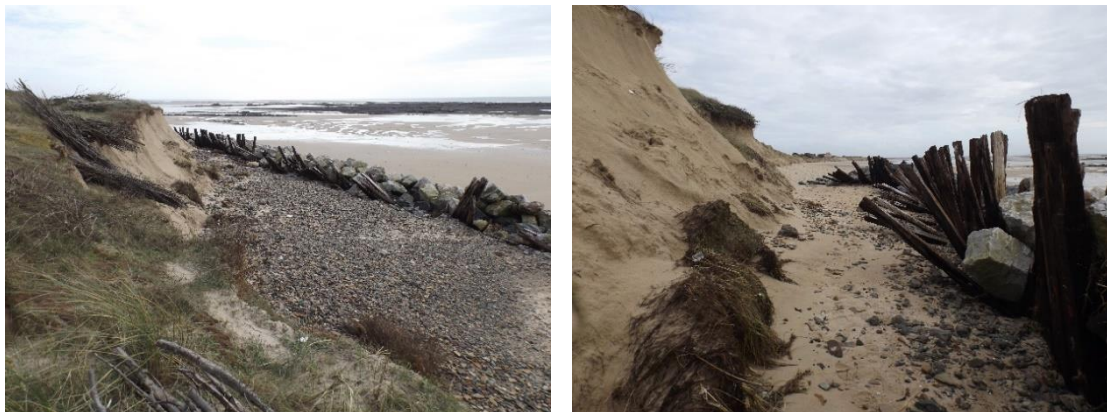
Figure 58. Etat de l'extrémité de l'ouvrage au 13 mars 2020 après la grande marée d'équinoxe de coeff. 116 (clichés COCM)
