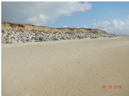
Figure 4. Erosion de la dune en arrière des enrochements... (cliché CASAGEC, octobre 2019)
