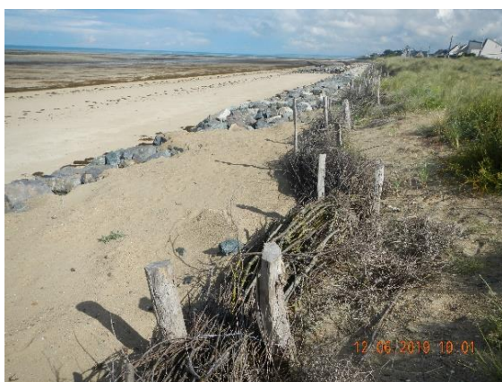
Figure 15. Fascines mises en place pour limiter l'érosion de la dune (cliché LITTO Consult, juin 2019)
