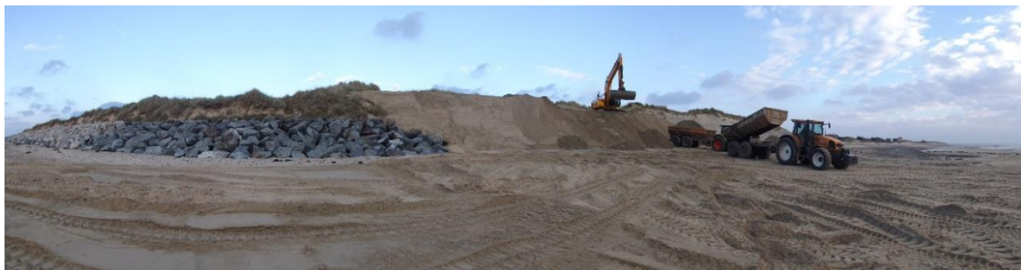
20 décembre 2016 : opération de rechargement en cours dans l'encoche d'érosion
