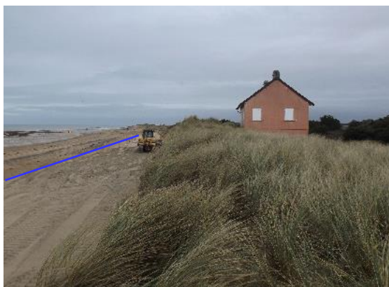
Figure 27. Illustration de la sape des sables de rechargements mis en place le 5 mars 2020, suite à la vive-eau d'équinoxe la semaine suivante (clichés COCM)
