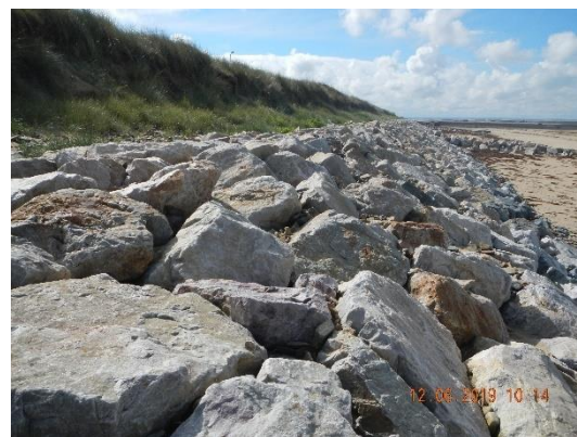
Figure 3. Vue du perré et des épis en partie centrale de l'ouvrage (cliché LITTO Consult, juin 2019)
