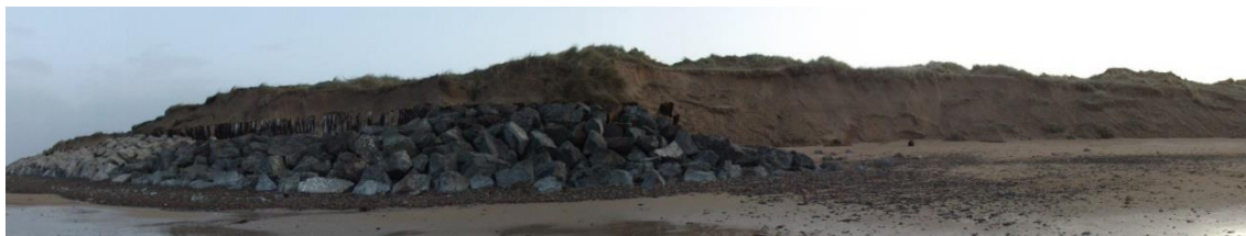
Figure 57. Etat de l'extrémité de l'ouvrage au 13 février 2020 après les tempêtes Ciara et Ines (clichés COCM)
