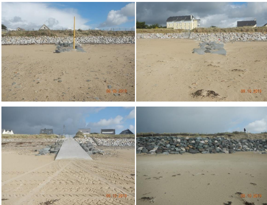
Figure 9 : clichés 2019 du perré, des épis, de la cale de la rue de Colmar et de la transition perré remanié / perré dégradé au Sud
