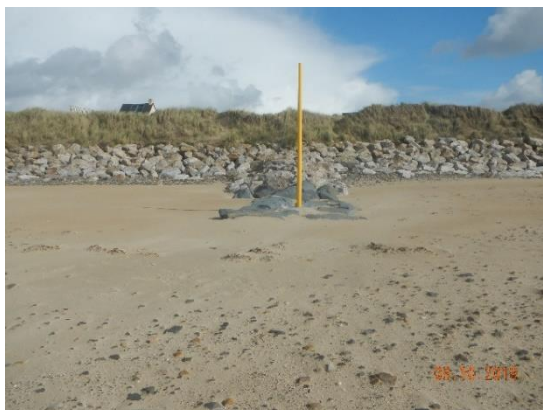
Epi expérimental en pieux + fascines à Pirou
