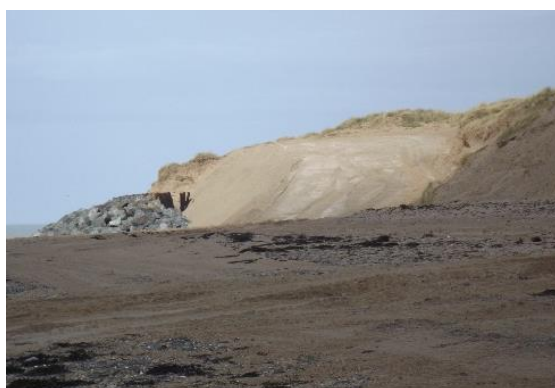
Figure 13. Illustration de la sape des sables de rechargements mis en place le 5 mars 2020, suite à la vive-eau d'équinoxe la semaine suivante (clichés COCM)
