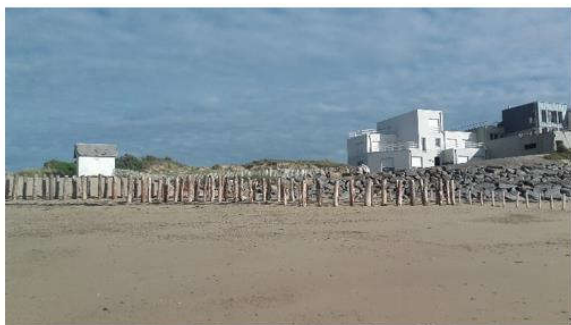
Pieux hydrauliques à côté des enrochements, Agon-Coutainville, La Poulette (11/10/17) © Coutances mer et bocage
