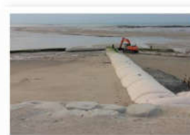
Epi géotextile en « T » à Gouville-sur-Mer (06/12/17 © photo Pays de Coutances)
