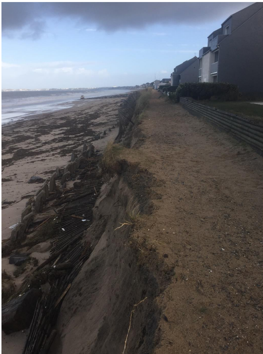
Figure 2 : Erosion du cordon dunaire et du chemin des douaniers suite à la tempête du 13 février 2020 - source : ASA FMCJ
