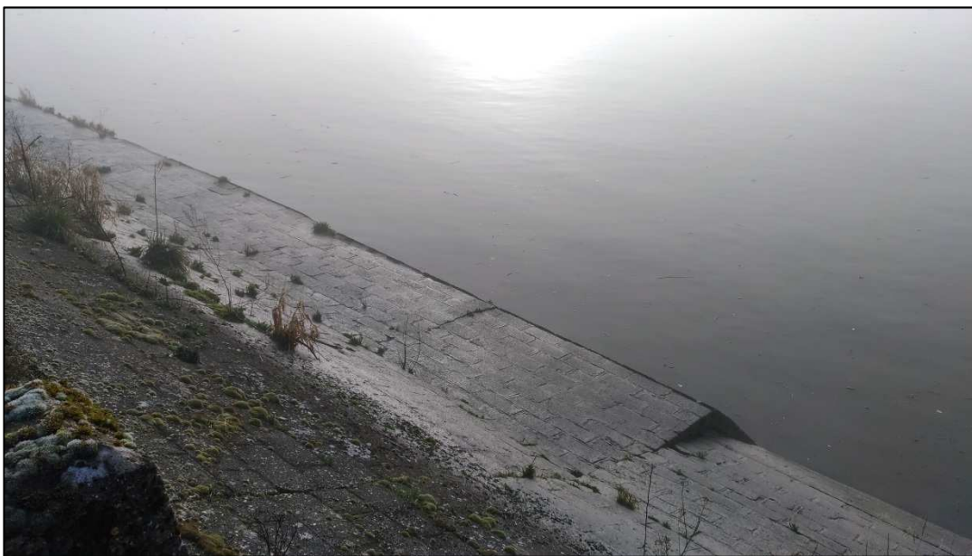
Deux exemples de dégradation du revêtement du perré : déformation en toit côté Seine à gauche et sous cavage à droite
