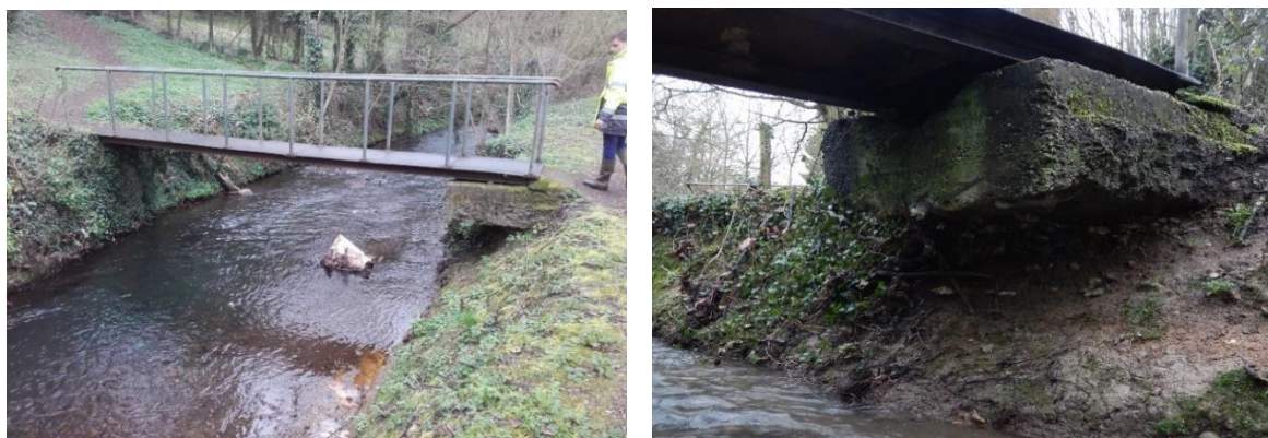
Fig. 42. Pied de la passerelle détérioré en rive droite
