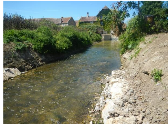
Fig. 25. Exemple de radier créé sur la Dives (Artelia)
