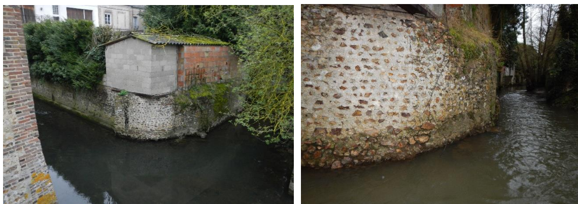
Fig. 28. Mur fragilisé sur le bras nord (Artelia)
