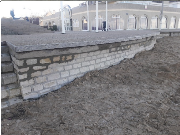
Rejointoiement et maçonnerie de moellons
