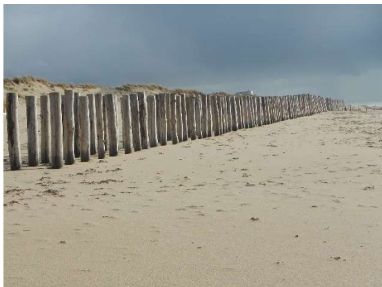
Pieux hydrauliques en pied de dune (Blainville-sur-Mer)
