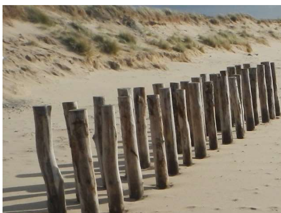
Pieux hydrauliques en pied de dune (Blainville-sur-Mer)
