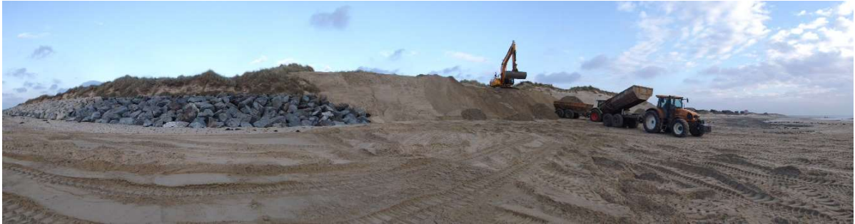
Figure 10. Illustration d'une opération de rechargement à Saint-Germain-sur-Ay (cliché CC COCM)
