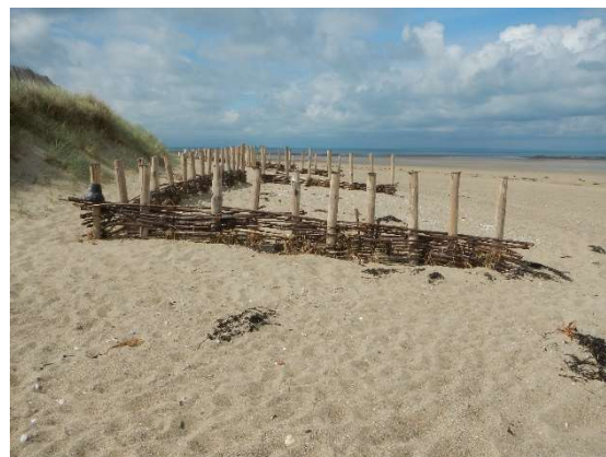
Fascines transversales et longitudinales (Saint-Pair-s/Mer)
