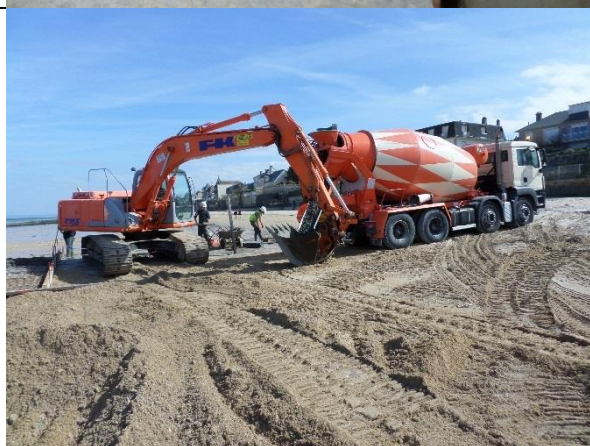
Langrune sur Mer Déchargement du béton dans le godet de la pelle
