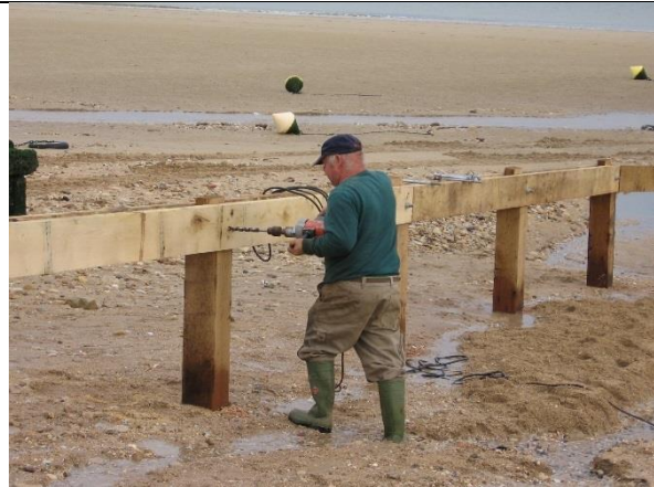
Mise en place des moises Perçage pour mise en place des boulons Groupe électrogène et perceuse électrique
