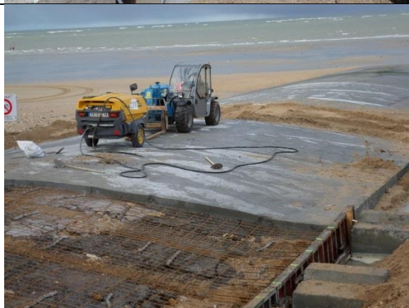
Bernières sur Mer Compresseur et aiguille vibrante Manuscopique pour déplacement du matériel
