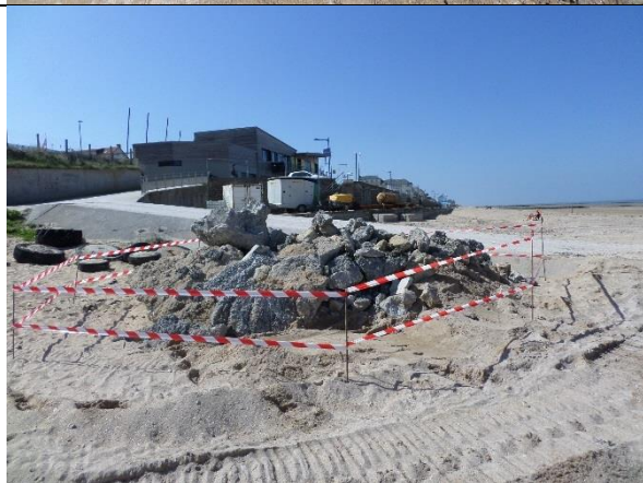
Langrune sur Mer Stockage et sécurisation des gravats En attente d'évacuation en décharge
