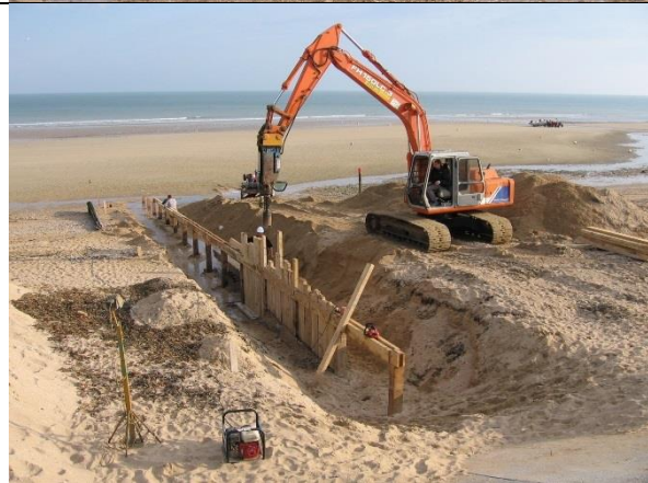
Mise en fiche et battage des planches
