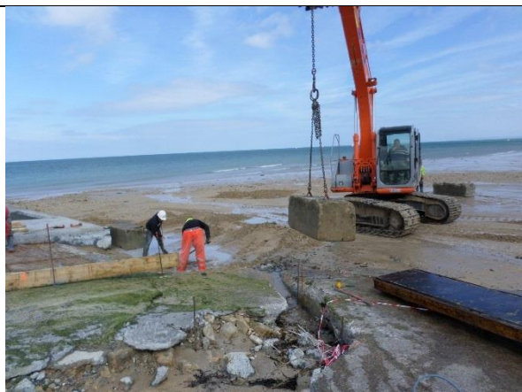
Langrune sur Mer Manipulation des blocs béton pour calage des banches
