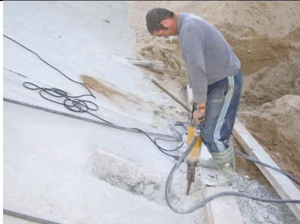
Création de la saignée dans la digue Compresseur et marteau piqueur pneumatique
