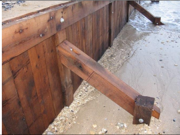
Mise en fiche et pose des bracons
