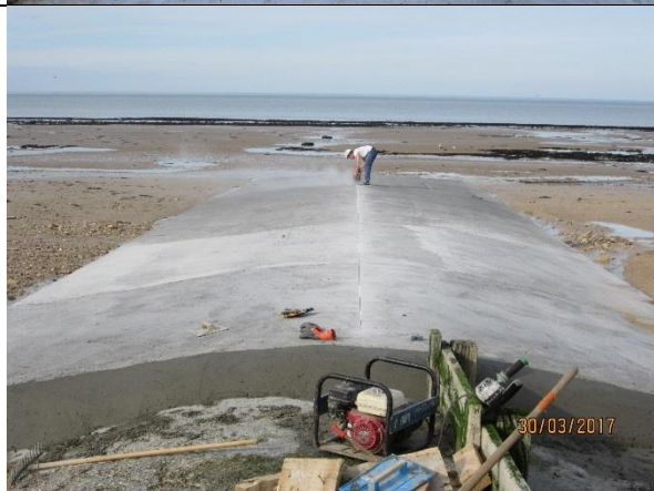
Saint Aubin sur Mer Réalisation du joint de pré fissuration Tronçonneuse thermique à disque
