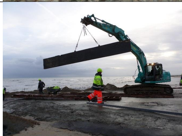
Saint Aubin sur Mer Manipulation d'un train de banches
