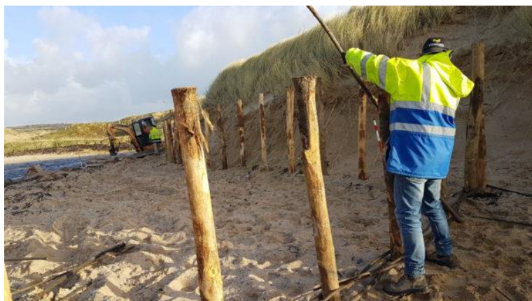
Phase de travaux de pose des fascines en bois
