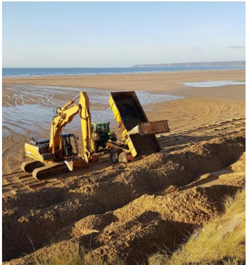
Mise en chargement du sable avant le fascinage de la dune ainsi reconstituée
