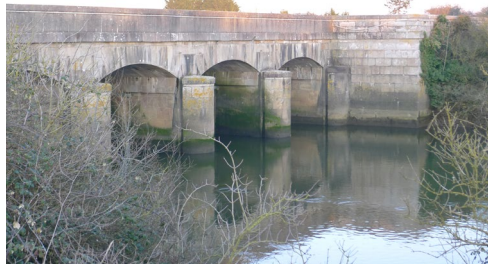
Isigny-sur-Mer. Le pont du Vey. Portes à flots.
