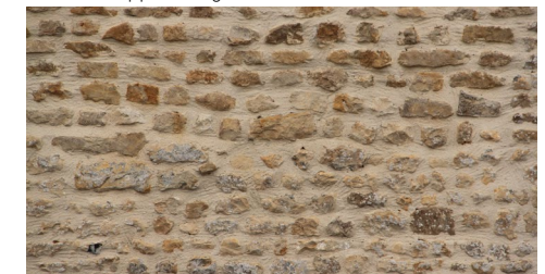
Grès schisteux, appareillage du territoire de transition.
