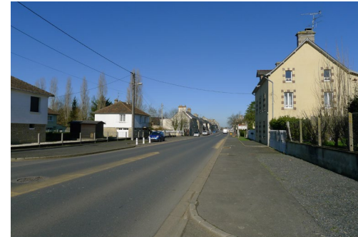
Lotissements le long de la route départementale à l'entrée du Molay-Litry.
