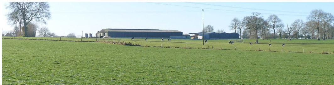
Exploitation agricole en bardage métallique sur les versants bocager en partie démembré. Cahagnes.
