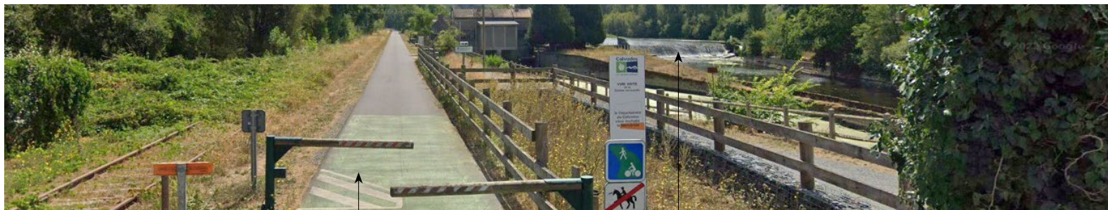
Voie verte, piste cyclable sur l'ancien tracé de la voie ferrée
