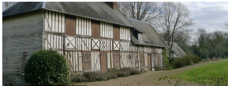
Maisons à pans de bois et ardoise typique du pays d'Auge.
