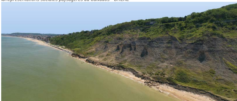
Auberville. Estran étroit, ponctué de blocs rocheux au pied des Vaches Noires.
