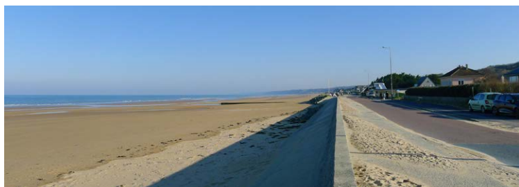
Digue et habitations gagnées sur le front de mer, Saint-Laurent-sur-Mer.
