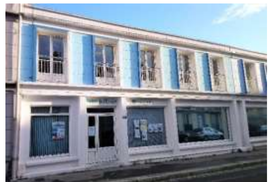
Figure 26 : Locaux administratifs (Le Havre)
