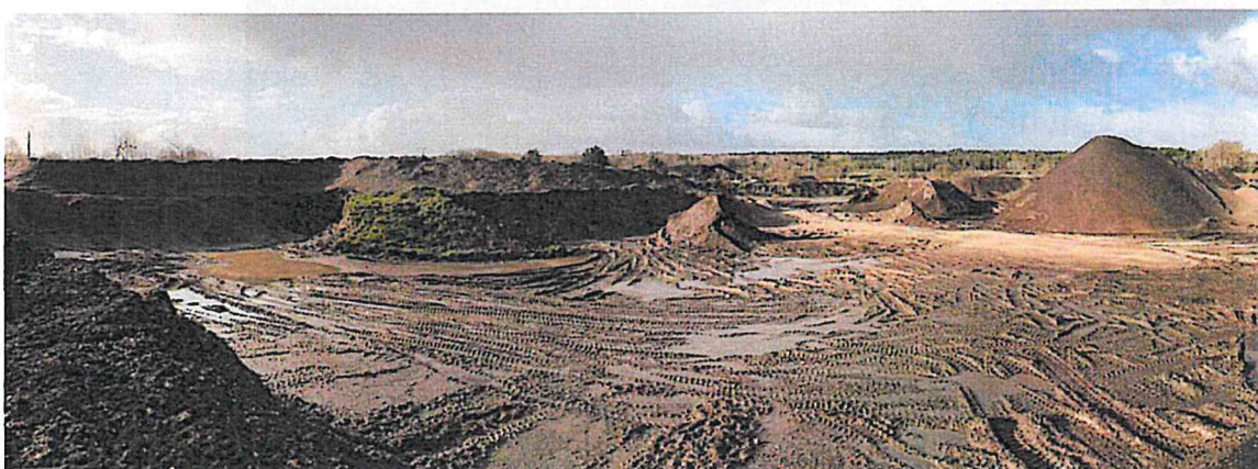
Zone de stockage et préparation
