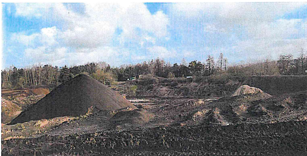
en contrebas de la RD 490 : -4 mètres, zone de stockage
