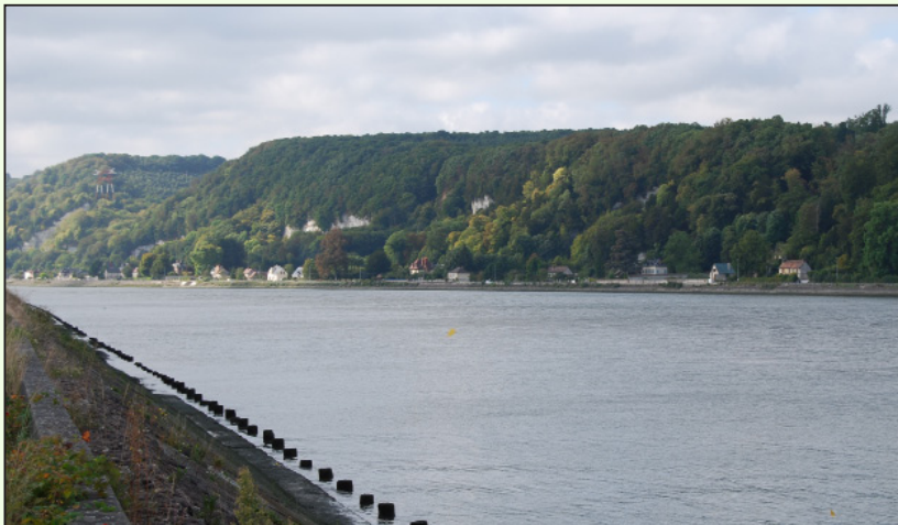
Les berges maçonnées mettent peu en valeur le bord de Seine.
