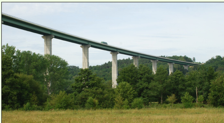
Les ponts-paysage : pont de la vallée de la Risle.
