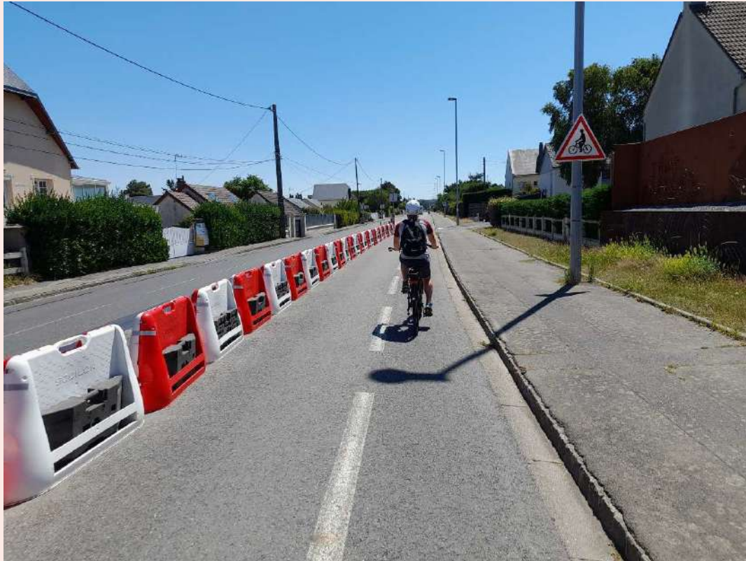
Piste cyclable transitoire à Saint-Pair-sur-Mer (photo Cerema)
