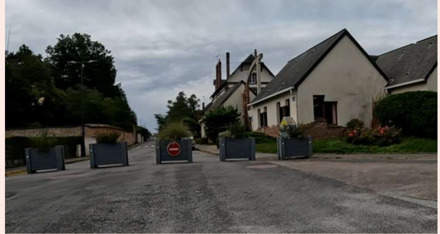
Mise en impasse perméable pour les modes actifs à Conches-en-Ouche (photo Cerema)
