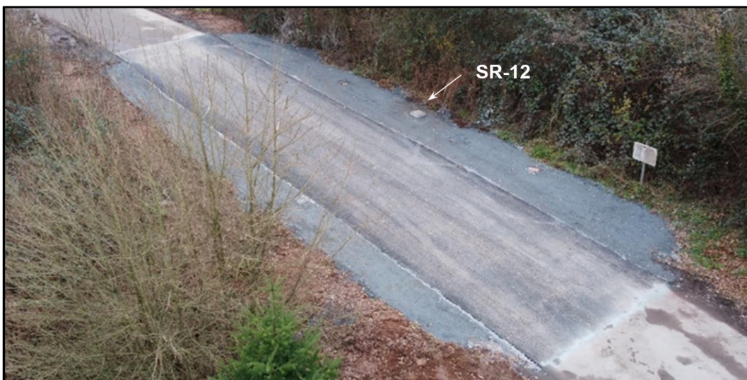
Figure 16 : RD 133, réalisation de la dalle au droit de la cavité (source : Rapport BRGM/RP-71555-FR).
