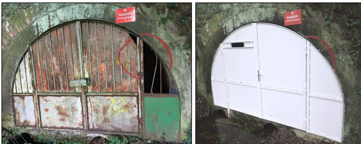
Figure 11 : Portail avant (à gauche) et après remplacement (à droite).
