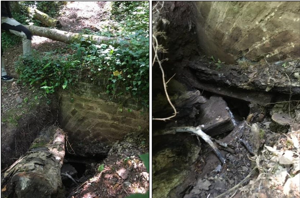
Figure 12 : Excavation à l'entrée de la galerie St. Quentin.
