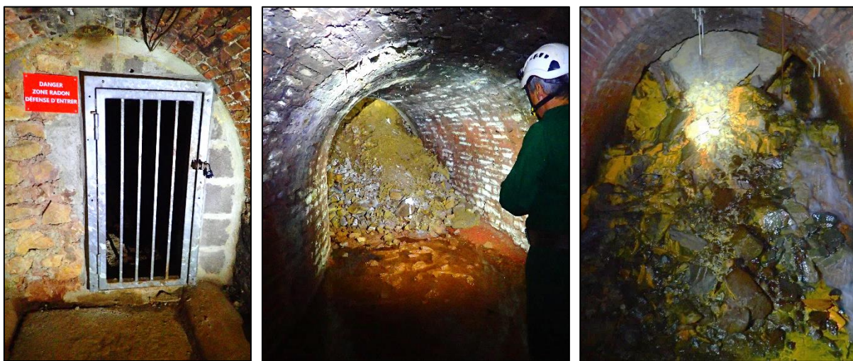
Figure 10 : TB de l'Orne, visite d'inspection par le fond en 2022.
