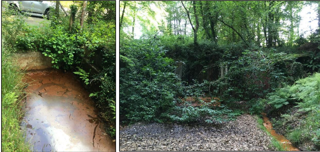
Figure 17 : Grille obstruée du fossé nord, rue de la Piscine (à gauche) et arbre déraciné (à droite).
