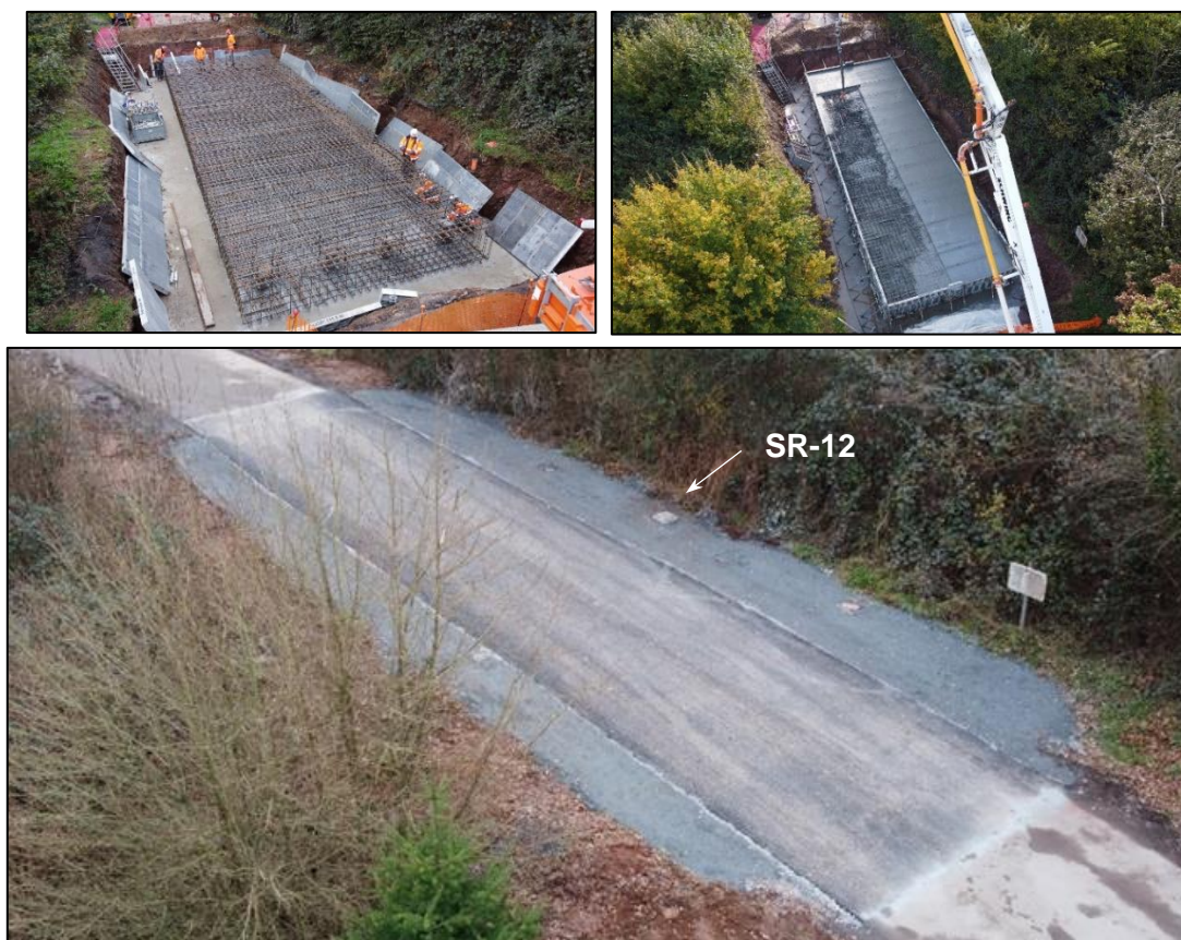
Figure 15 : RD 133, réalisation de la dalle au droit de la cavité (source : Rapport BRGM/RP-71555-FR).
