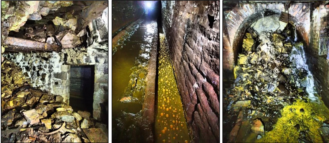
Figure 10 : TB de l'Orne, visite d'inspection par le fond.
