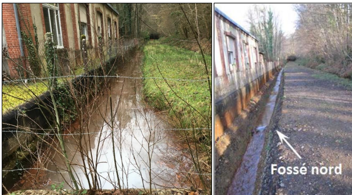
Illustration 16 : TB 220, fossés aval (avant et après curage).
