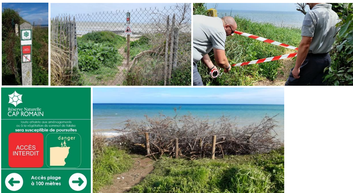
Figure 15 : photos des travaux de fermeture de la brèche du square des Canadiens par l'équipe régie
