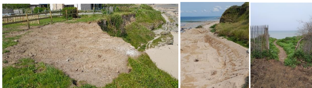
Figure 14 : photos d'infractions ayant un impact sur l'enjeu géologique (photos 1 et 2 : travaux sans autorisation, photo 3 : dégradation des aménagements)
