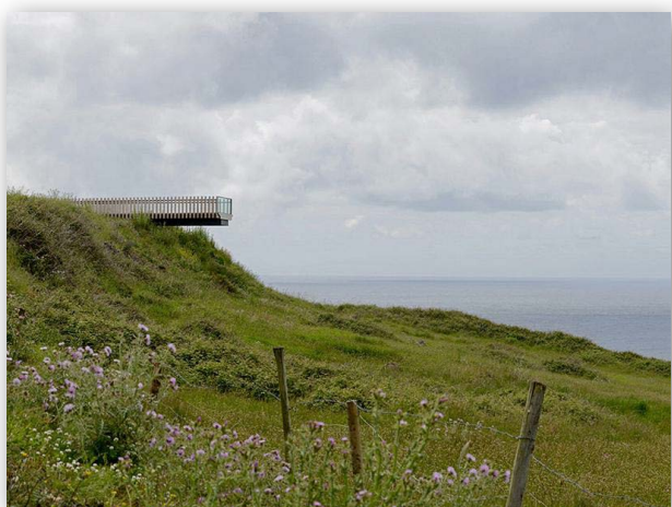
Belvédère ponton ponctuel - Porto
