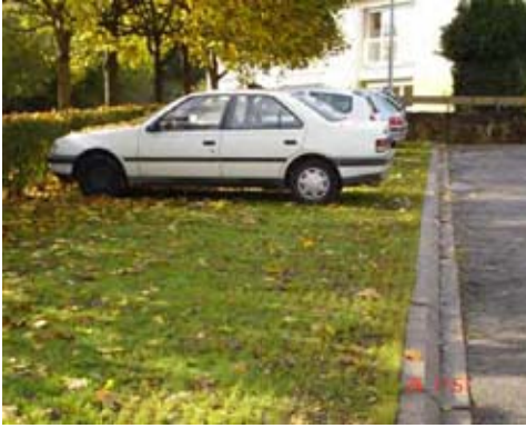
Parking engazonné perméable
