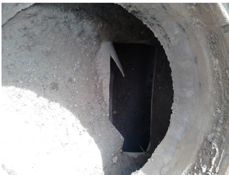
Photographie 10 : Regard n°19 dépôts de terre conséquent
