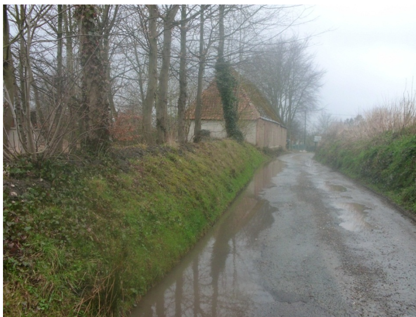
Photographie 3 : Ecoulement sur voirie située entre 2 talus cauchois (photo n°2 sur la carte en annexe 4)
