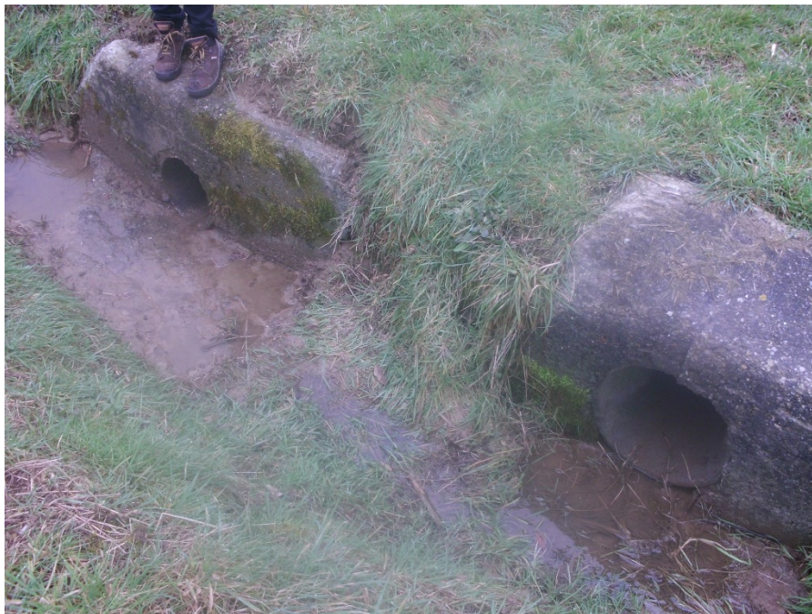
Photographie 6 : 2 passages busés à l'exutoire du bassin versant (photo n°4 sur la carte en annexe 4)
