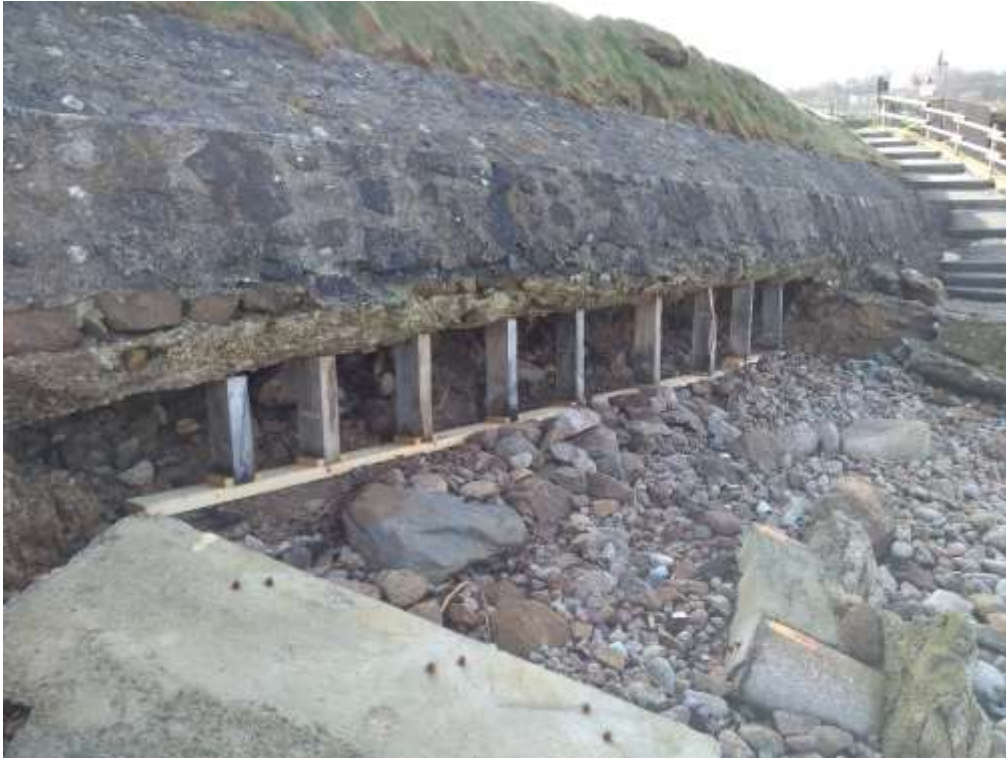
Photo 3 : Semelle béton à sécuriser (source : CAC/DCE-GEMAPI – le 9 mars 2020)
