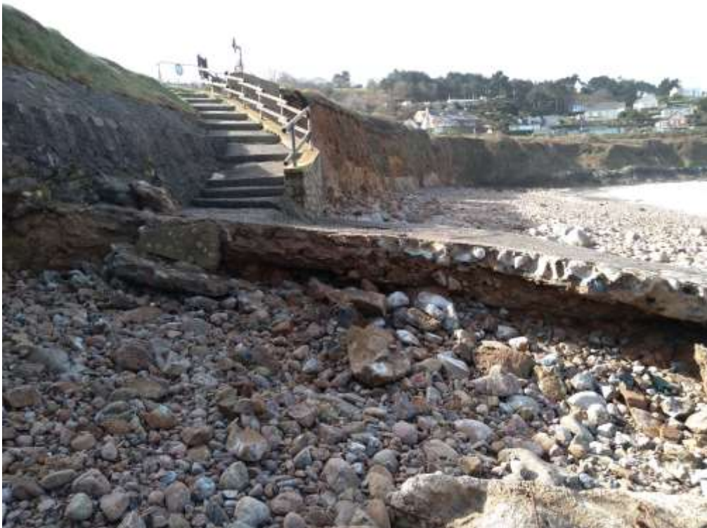
Photo 3 : Semelle béton à sécuriser (source : CAC/DCE-GEMAPI – le 9 mars 2020)
