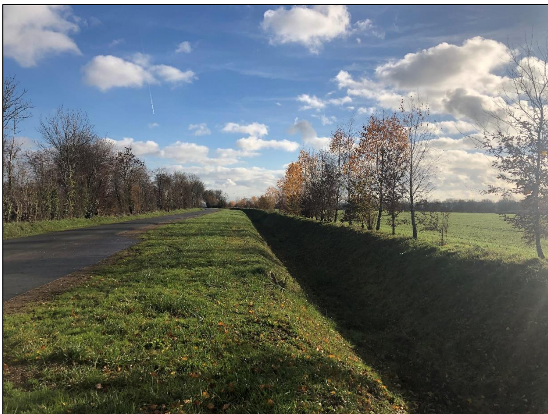
Photo n°2 : Voie actuelle longeant les futures parcelles du projet – La haie est conservée
