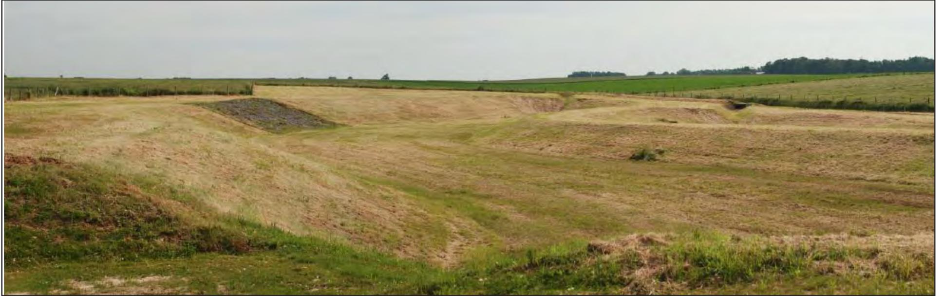
*La propension de l'eau à filer dans les vallées peut provoquer de fortes inondations lors des épisodes pluvieux intenses. C'est pourquoi des retenues d'eau ou bassins d'orage sont aménagés sur les plateaux pour ralentir l'écoulement de l'eau dans les vallées habitées.*
