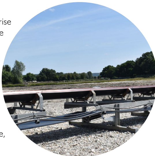
Installation de bandes transporteuses / L. Lemonnier
