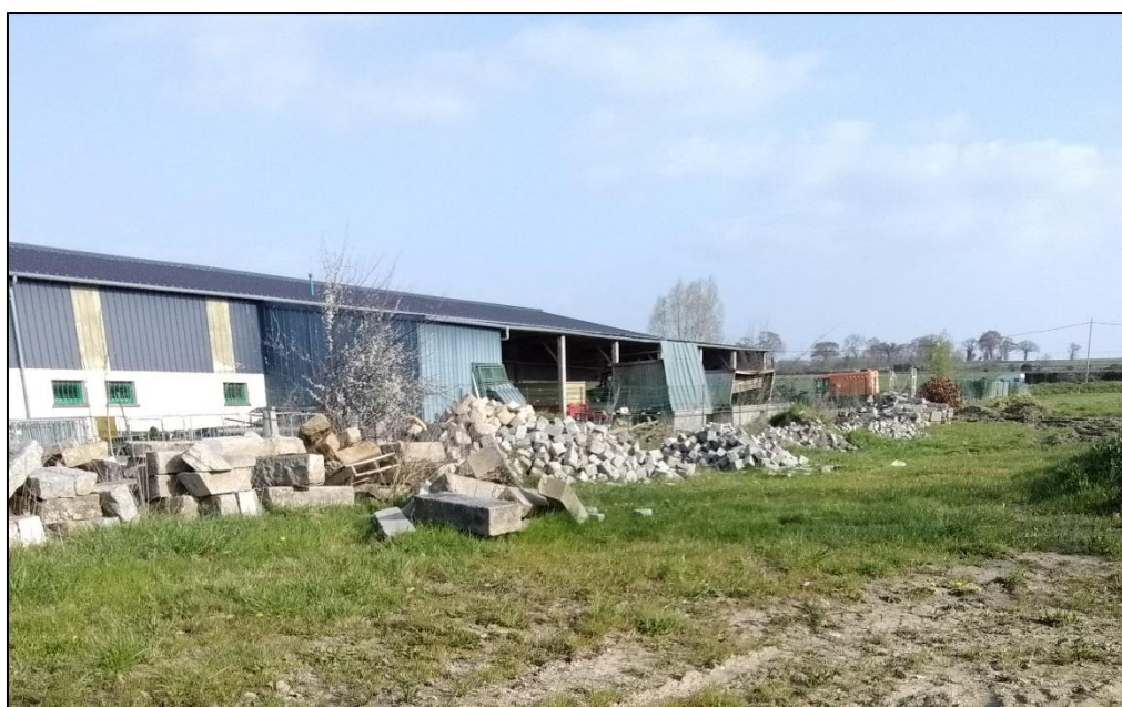
Photo 1 : Vue du bâtiment des services techniques qui sera démoli (Angle de vue « A »)
