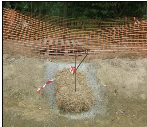
Photo 3 : Emplacement de bottes de paille en phase travaux, dans un bassin d'orage et un cours d'eau
