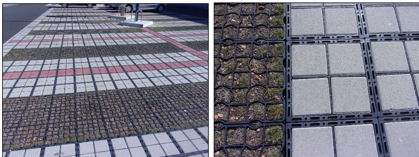
Photo 2 : Exemple de parkings en pavés drainants – Magasin LIDL de Noyal-Châtillon-sur-Seiche
