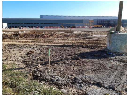
Abords du projet : plateforme logistique de GEMFI
