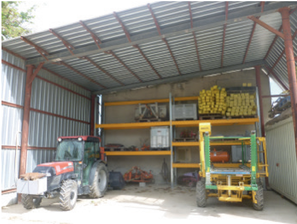
Photographie 3 : Installation d'étagères métalliques pour sécuriser le petit matériel
