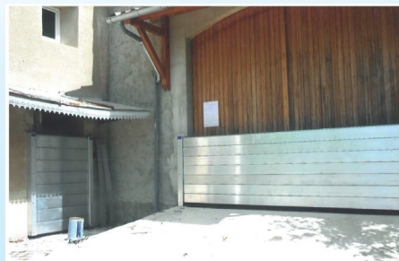
Photographie 1 : mise en place de batardeaux (CA26).
