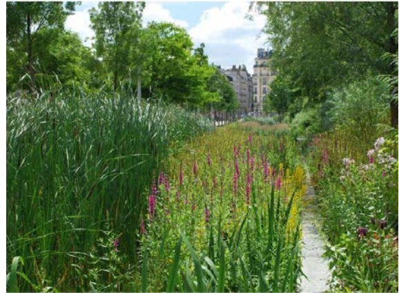
➡ Noues, fossé humide, bassin biotope collectent en surface les eaux pluviales avant infiltration dans le sol. ⬅
