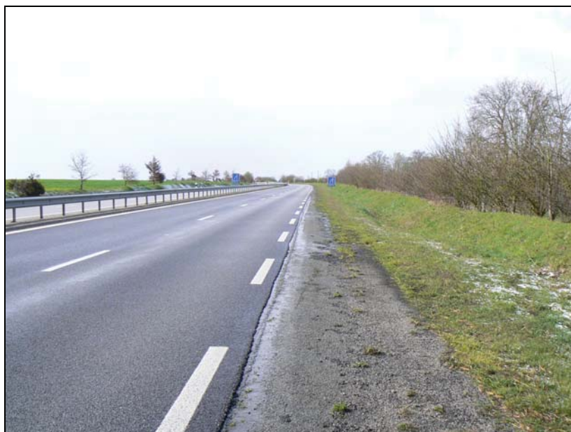
Accotement non revêtu sur 2x2 voies sur la RN12
