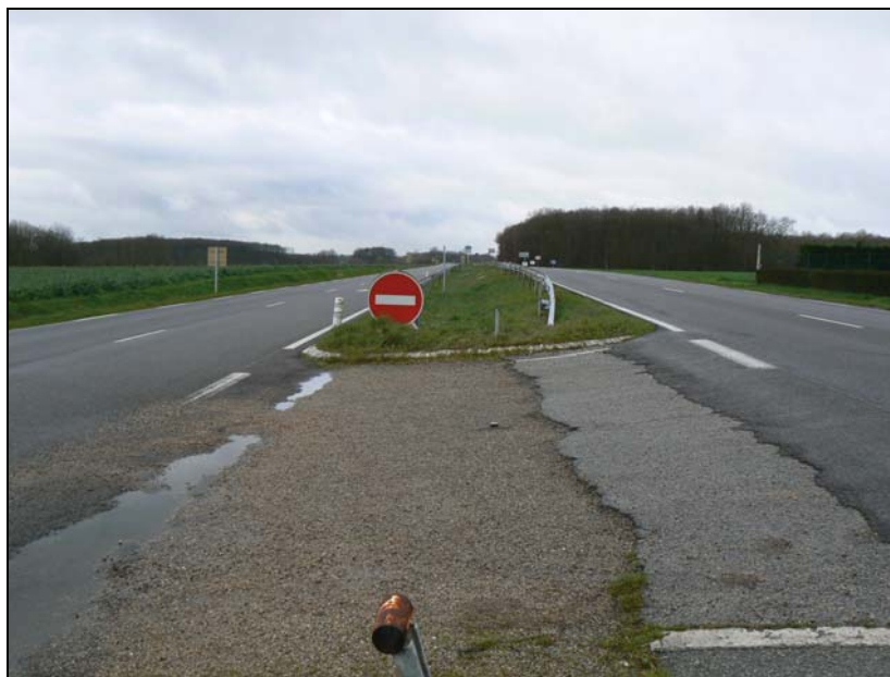
Ouverture du TPC sur la RN12 dans l'Eure
